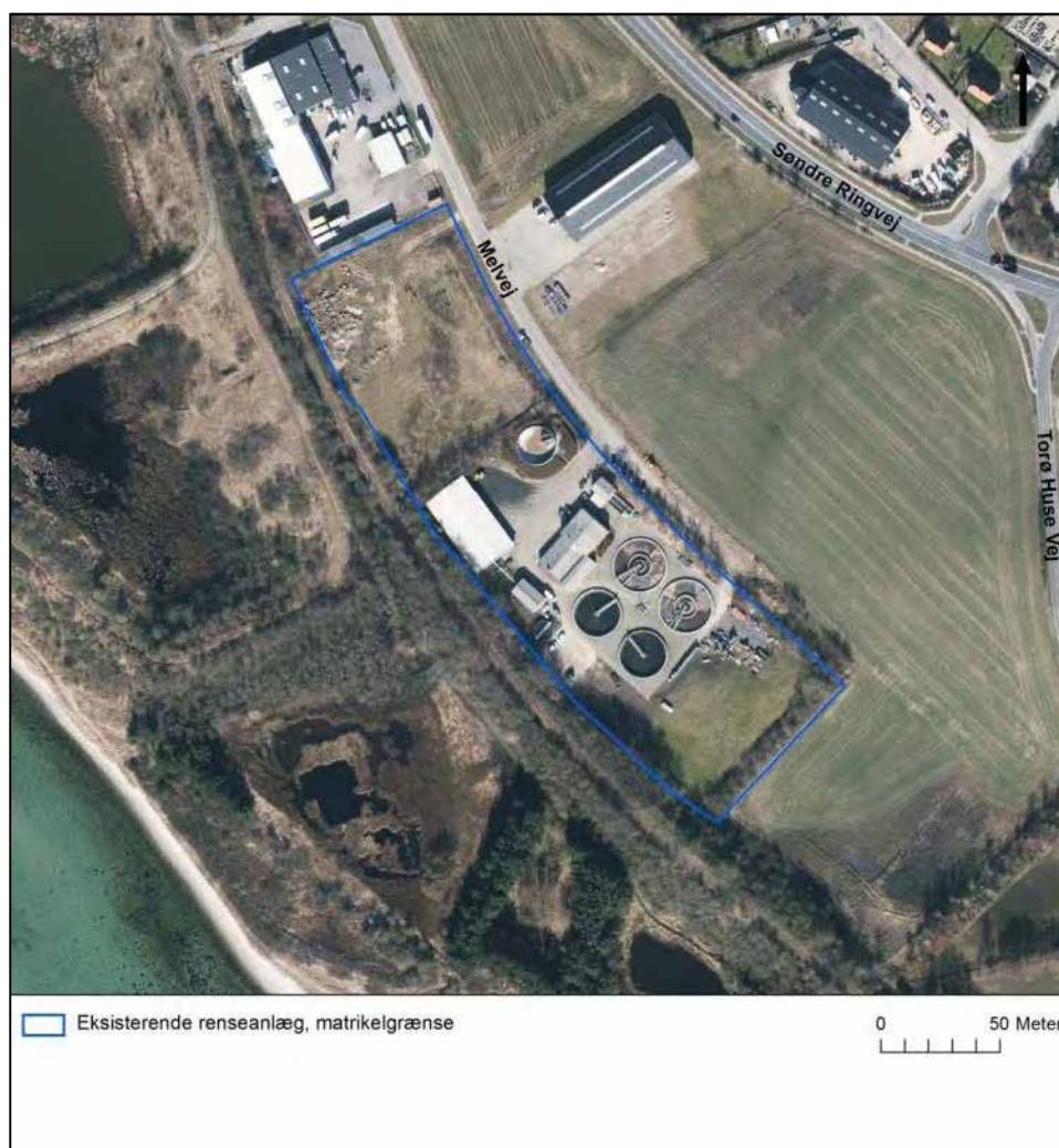
Figur 2.2 Det eksisterende reaseanlæg ved Melvej 10.
