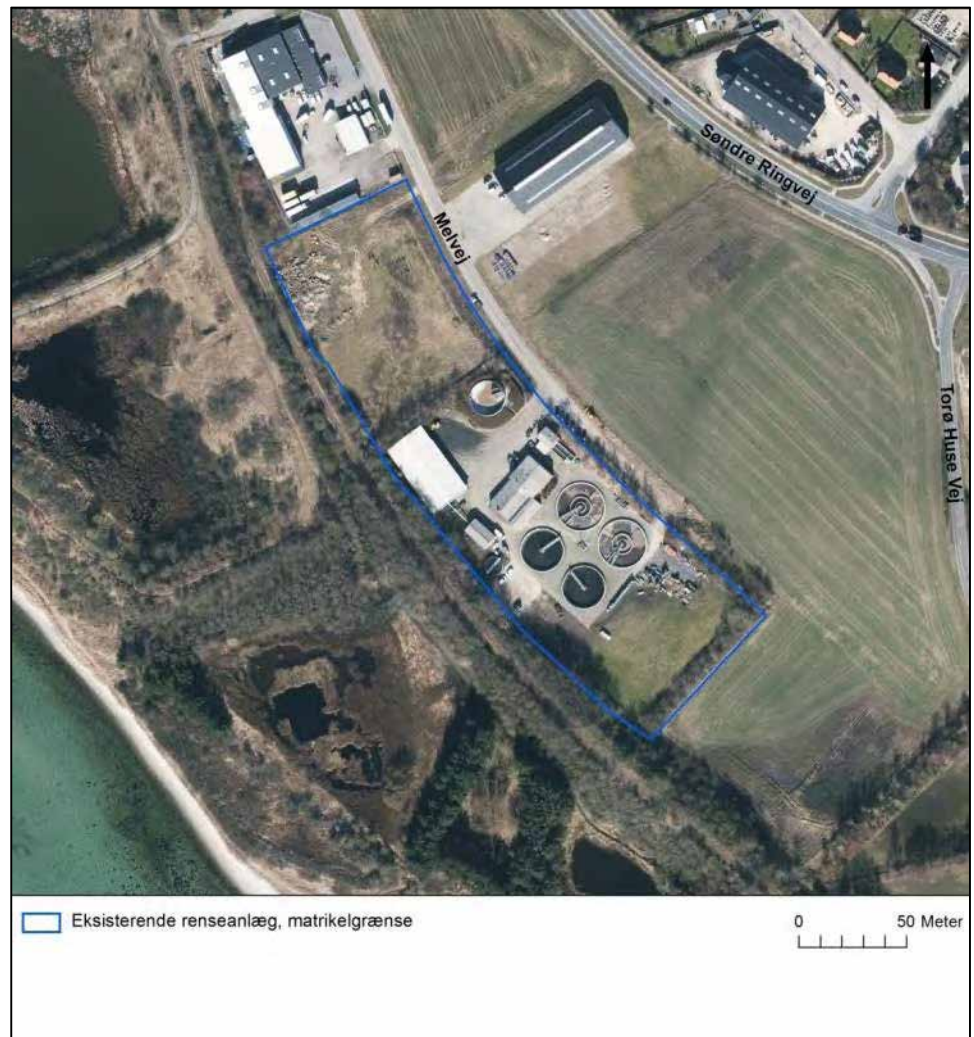
Figur 2.2 Det eksisterende renseanlæg ved Melvej 10.
